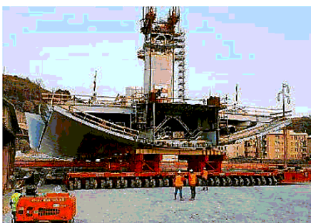
Al lavoro. Due aziende bresciane impegnate nella costruzione delle campate
