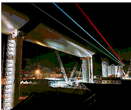
Di notte. Uno scorcio del viadotto sul Polcevera
